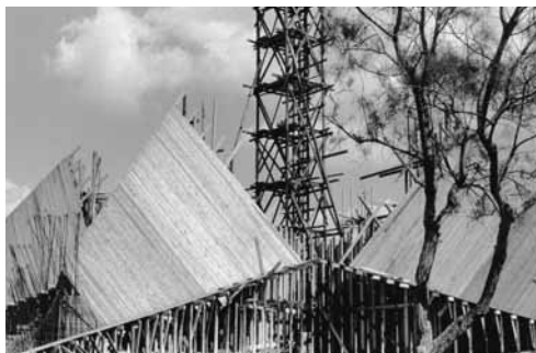
[9] אריה אלחנני, יריד המזרח, גני התערוכה, תל-אביב, 1959: תבנית ליציקת הכיפה [10] נחום זולוטוב, בית הכנסת של התאחדות עולי בבל, באר-שבע, שנות ה-70, בבנייה
